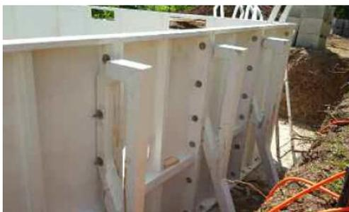
Contrafforte FULL viene utilizzato per tutte le piscine da realizzare a bordo sfioro, la parte superiore piana, permette la posa di travi in cemento bianco o di realizzare un getto in CIs per il sostegno del bordo in cemento bianco.
